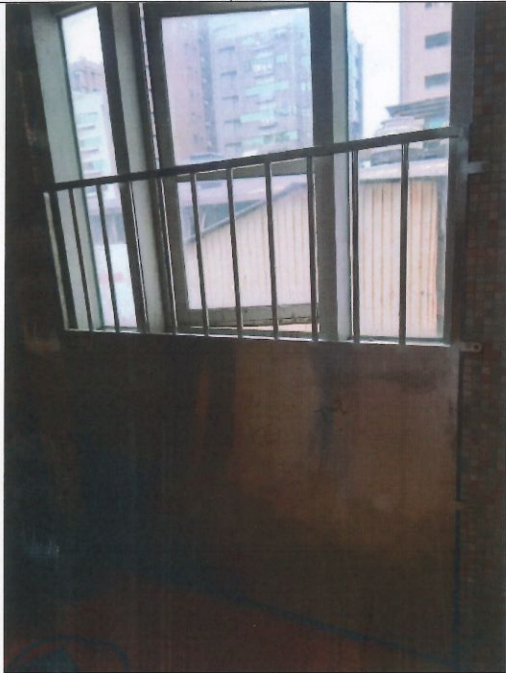
4樓籃球場格柵及鐵板修繕
