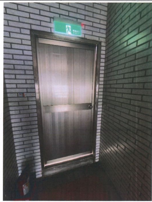
7樓頂樓鋁門修繕
