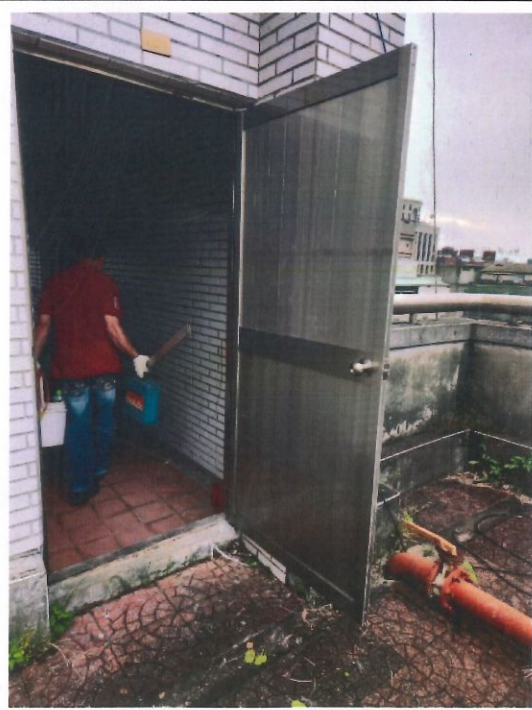
7樓頂樓鋁門修繕
