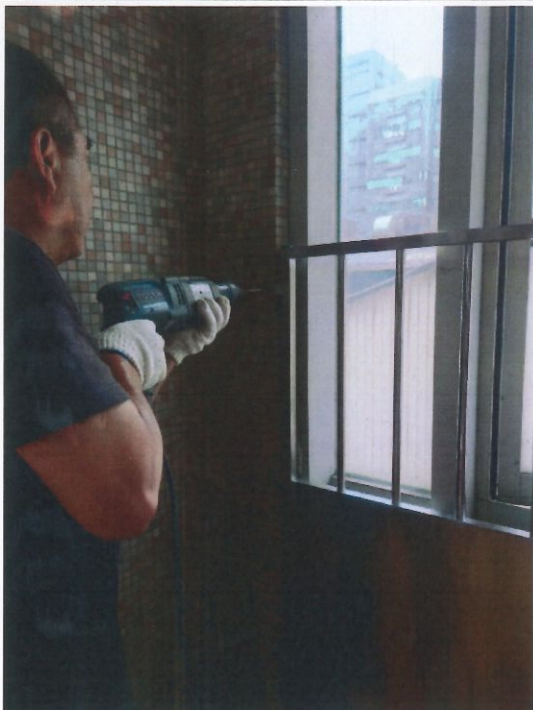
4樓籃球場格柵及鐵板修繕
