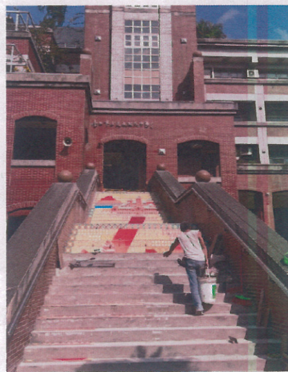
施工過程-貼磚
