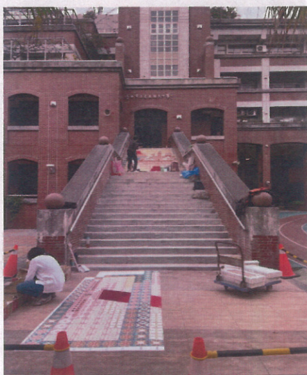
施工過程-貼磚
